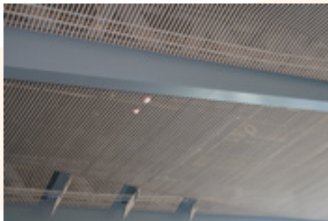
Røykdetektorer i taket.
