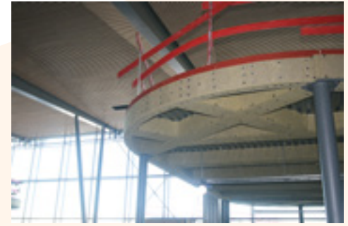
Brannisolering i mesanin.
